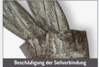
Beschädigung der Seilverbindung
